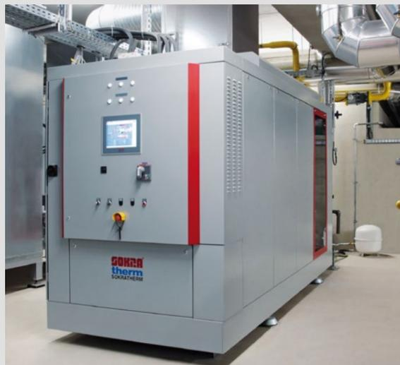
Ein zentrales **Gas-Blockheizkraftwerk** in Gebäude A versorgt die KfW-Effizienzhäuser des Quartiers sparsam mit umweltfreundlicher und kostengünstiger Energie. Dabei wird gleichzeitig Strom für den Eigenbetrieb und Wärme für Heizung und die Warmwasserbereitung gewonnen. Die Energieeffizienz liegt etwa doppelt so hoch wie bei herkömmlichen Heizungssystemen.
